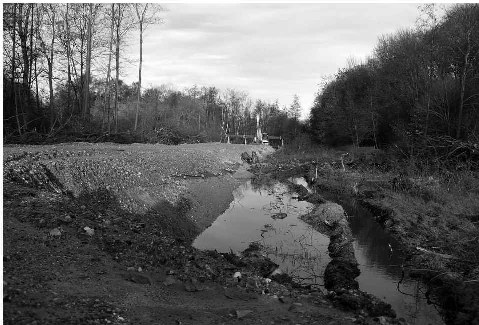
Billedet er taget få meter til venstre for fårestalden med ryggen mod Rugårdsvej. I baggrunden skimtes en rendegraver og det gamle kloakrør på stylder. Foto: Kuréren
