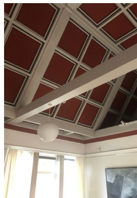
De røde kassetter, som skal udstyres med lyddæmpende plader. Foto: Hanne Sørud
