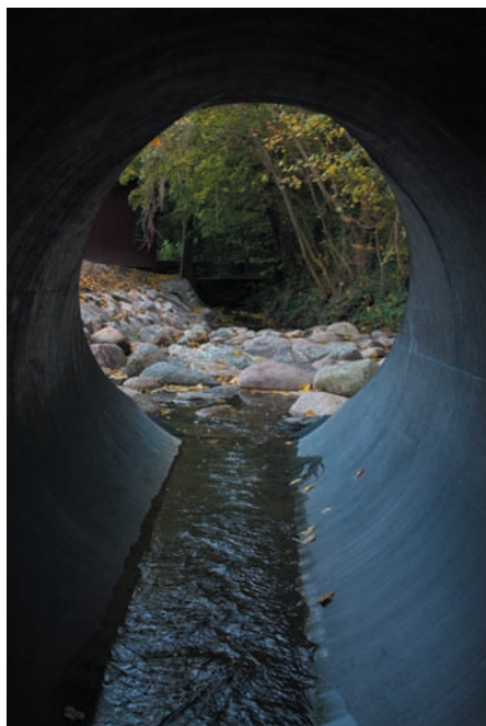
Og sådan ser den nye stensætning ud inde fra røret. Foto: Jacob H. Faarup
