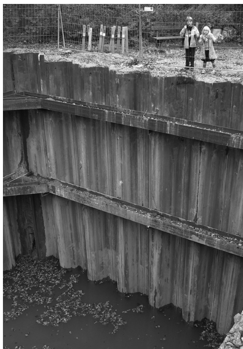
På overfladen ligner boldbanen sig selv, men kommer man tæt på, kan man se, hvor dybt hullet er. Foto: Kuréren
