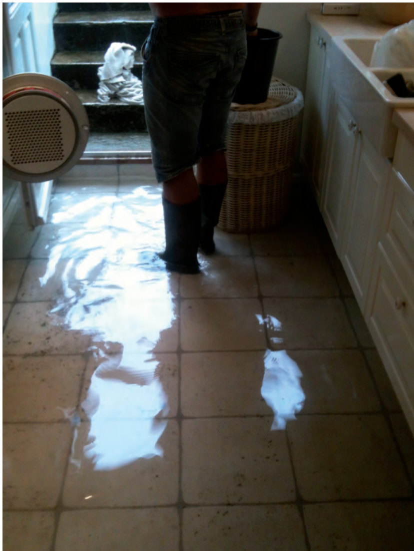
Denne kælder på Dronning Olgas Vej slap forholdsvis mildt fra skybruddet 28. juli. Men hvad med din kælder? Skriv til: vandikaelderen@gmail.com og beskriv, hvornår du har haft vand i kælderen. Foto: Dorte Riber
