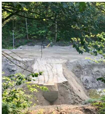
Den kommende trappe fra Langesøstien til Kærlighedsstien.
