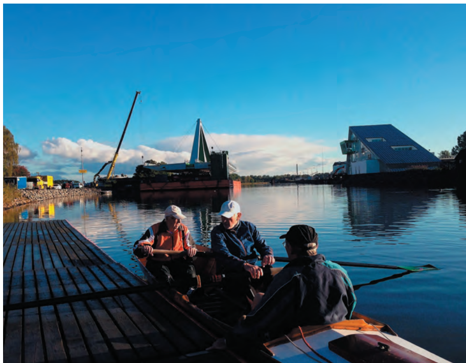
11. og 18. september er der mulighed for at komme helt tæt på det nye havnekontor (bygningen til højre) og den helt nye Odins Bro. Billedet her er taget den smukke septembormorgen i 2013, da det første brofag ankom fra Kina. Foto: Kuréren
