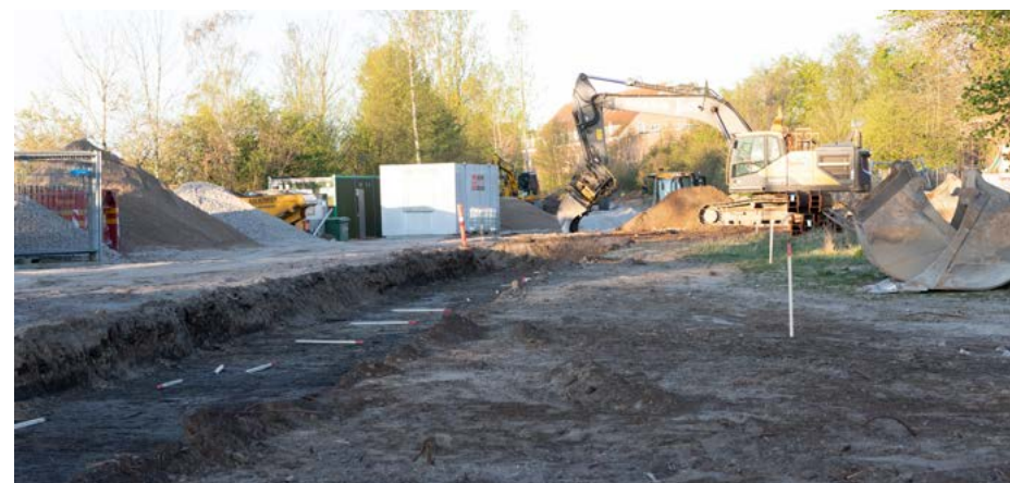
Det grønne område bag Åløgkeskolen er nu en byggeplads. Foto: Claus Thorup
