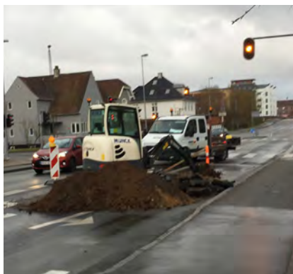
Vejarbejde på Åløkke Allé. Der er gamle trærodder under asfalten.
