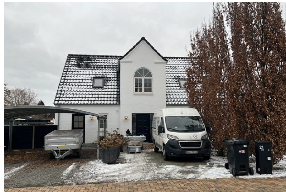
Mogensensvej 21 blev opført i 2013 på en grund, der i mange år havde været parkeringsplads. Foto: Kuréren
