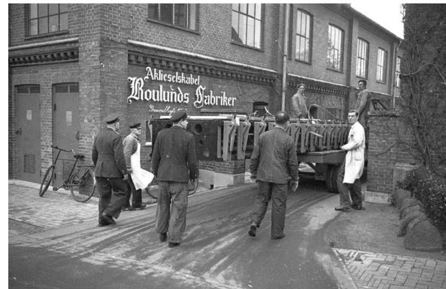
Roulunds fabrikker 1953: Et stort stykke maskineri var ankommet med jernbane fra Tyskland. Det skulle bruges til fremstilling af transportbånd, var 10 meter langt, vejede 25 ton og var støbt i ét stykke. Her er Falck ved at hjælpe det ind gennem porten til fabrikken på Rugårdsvej 101. Foto: Fyens Stiftstidendes pressefotosamling, Odense Stadsarkiv
