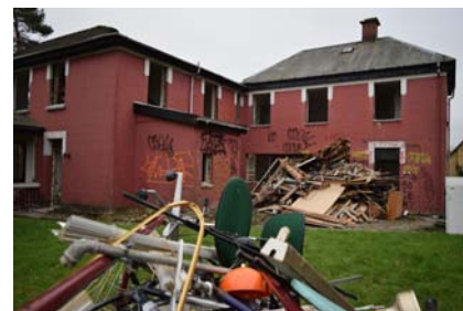
Bagfra ser man tydeligere, at huset snart er ryddet og klar til nedrivning.
